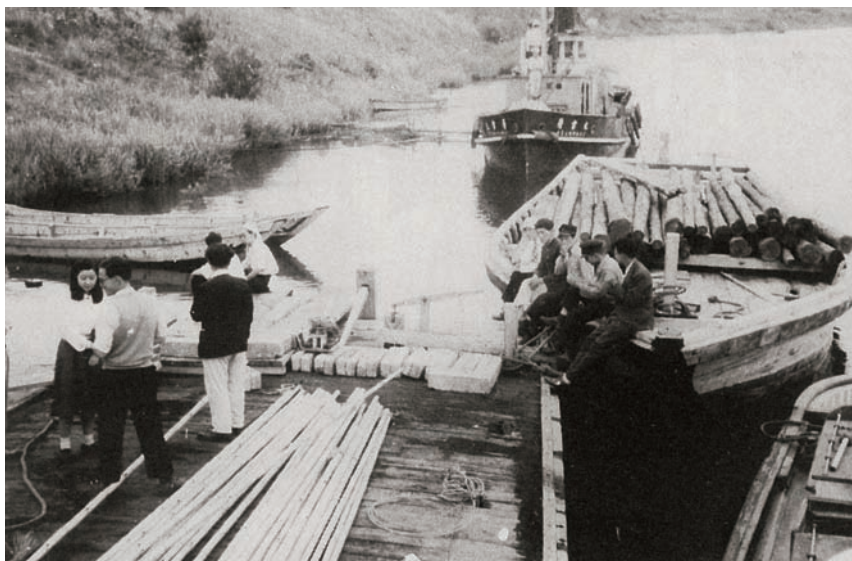
石狩漂砂調査(1949年) 後ろ姿が池田芳郎。池田自身も観測船に乗り込み、調査をした。手前には、池田が考案した漂砂計測用竹棒が見える。竹棒は「北大方式」と呼ばれた漂砂採集器で、節毎に穴をあけて海・川底にさすと堆積した砂が計測できた。(溝口百合子氏提供)
