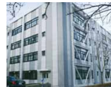
改修した北図書館
