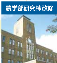
農学部研究棟改修 公共施設等の建設、維持管理、運営等を民間の資金、経営能力及び技術的能力を活用して行う「PFI」という新しい手法が用いられました。
